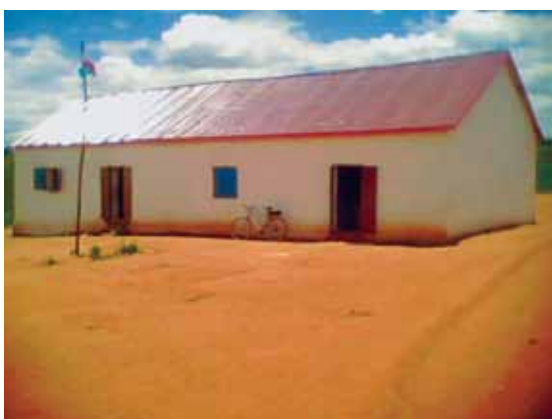
Des toitures rénovées
